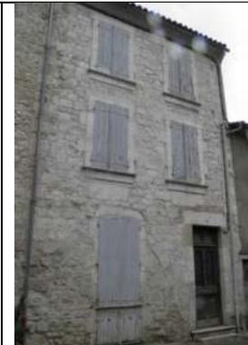
Exemple de maçonnerie médiévale en maçonnerie appareillée destinée à rester apparente.
