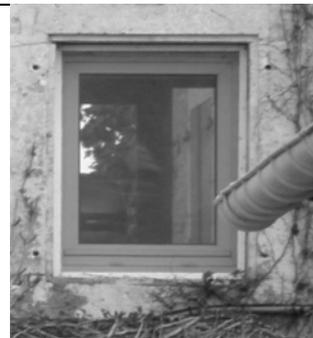
Les menuiseries traditionnelles sont en bois. Les fenêtres sont à carreaux moyens et les contrevents à traverses, voire à écharpes opposées.
