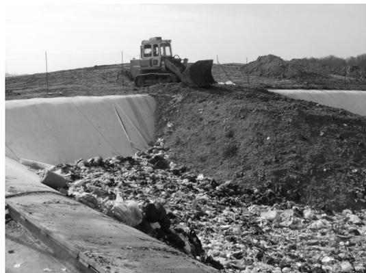
La décomposition des matières organiques produit 2 types de nuisances : la production de « lixiviats » (jus de poubelle) et de biogaz. Les premiers sont traités dans des stations d'épuration sur site et les seconds sont brûlés avec production d'électricité (équivalent 40 000 foyers).
